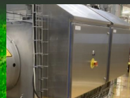
Nuevo diseño higiénico de cofre de acero inoxidable (1.4404; AISI 316) con todos los sensores.
